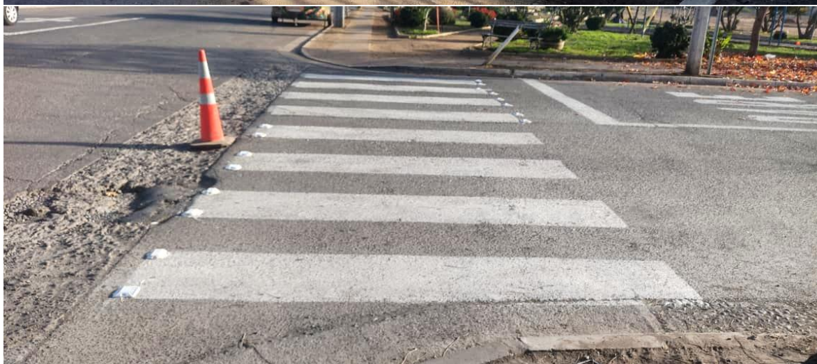
Pje. Padre Pio X: borrado de demarcación existente (línea detención antigua)
