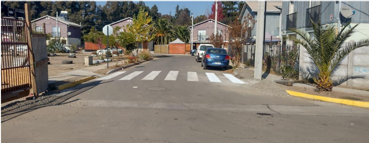
Calle Juan Pablo II : instalación valla peatonal en acceso a colegio
