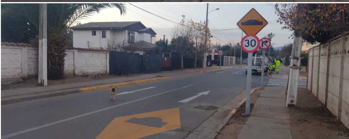
Calle Pablo Neruda (sur): instalación de señales verticales
