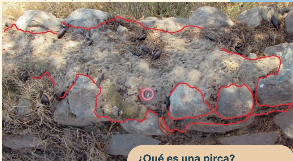
Figura. 2. Detalle del muro de pirca. Se aprecia el uso de piedras unidas con barro y otros materiales naturales, una técnica tradicional que aprovechaba los recursos disponibles en el entorno.
